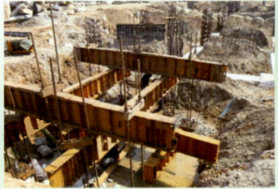
ภาพแสดงการติดตั้งอุปกรณ์เพื่อทดสอบ การรับน้ำหนักของเสาเข็มโดยวิธี Static Load Test
