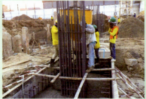
ภาพแสดงการยกคอนกรีตฐานราก
