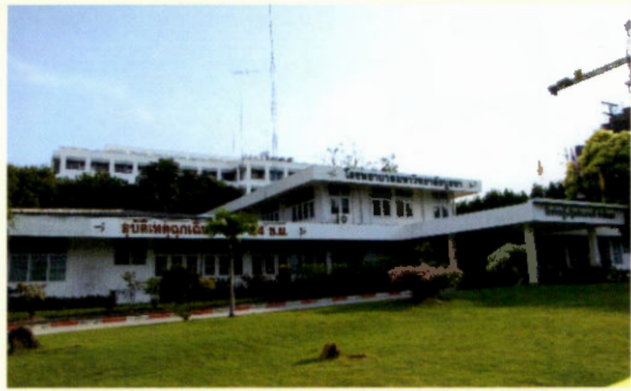
ภาพอาคารท่านผู้หญิงประกาศรี กำสังเอก (ระหว่างการก่อสร้างอาคารสมเด็จพระเทพรัตนราชสุดา) บันทึกเมื่อ ๑๑ มกราคม พ.ศ. ๒๕๕๒
