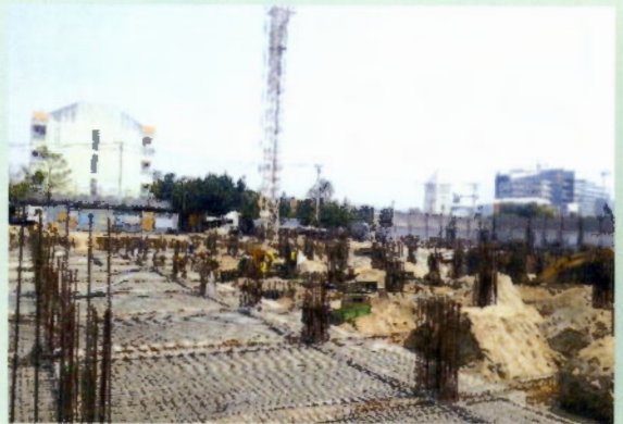
ภาพแสดงการลงเหล็กเสริมพื้นชั้นใต้ดิน
