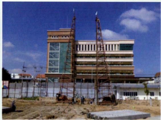
ภาพแสดงการตอกเสาเข็ม
