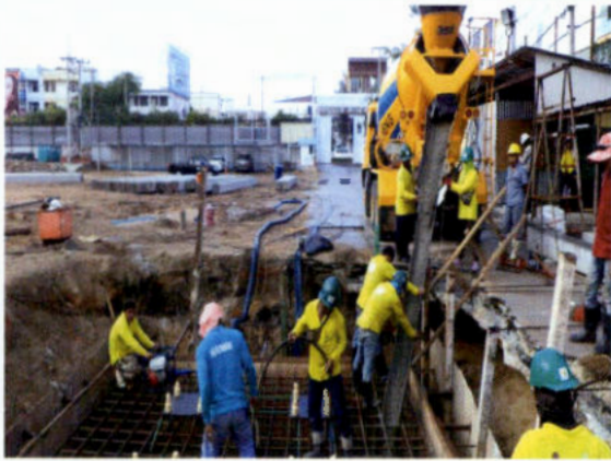
ภาพงานเทคอนกรีตฐานราก Tower Crane
