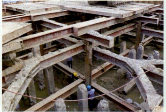
ภาพแสดงการตัดหัวเสาเข็มบริเวณที่เก็บน้ำใต้ดิน
