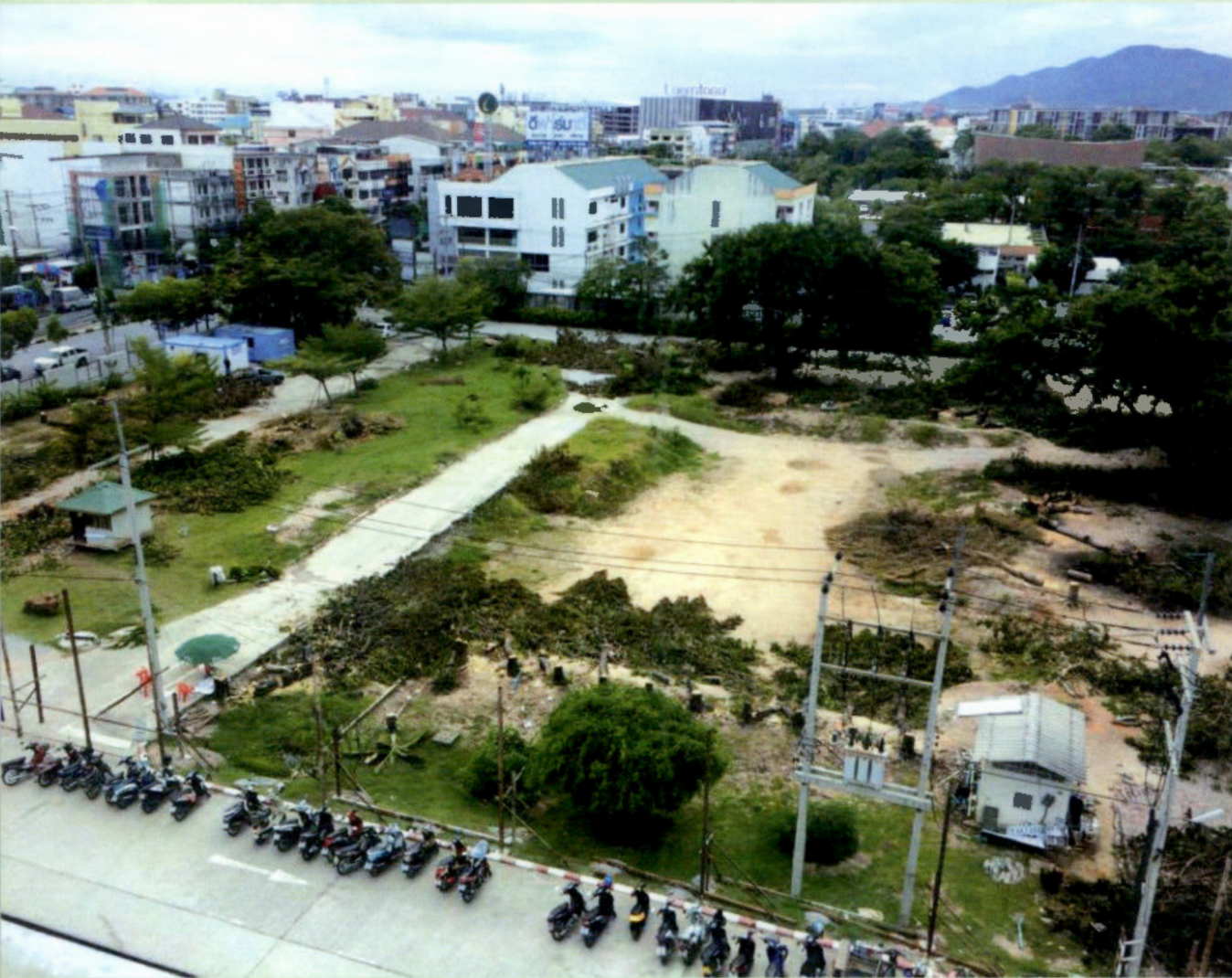
ภาพมุมสูงแสดงการเตรียมพื้นที่หลังการรื้อถอน อาคารท่านผู้หญิงประภาศรี กำลึงเอก บันทึกเมื่อวันที่ ๑ กันยายน พ.ศ. ๒๕๕๘
