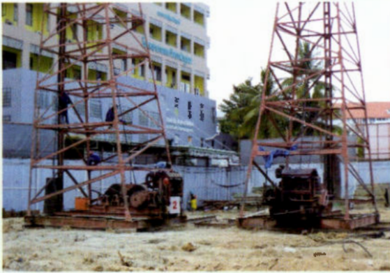
ภาพแสดงการตอกเสาเข็ม
