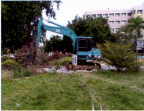
ภาพแสดงการเข้าเคลียร์พื้นที่ก่อสร้าง
