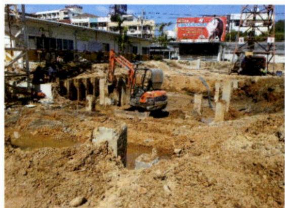
ภาพแสดงการเปิดหน้าดินเพื่อตัดหัวเสาเข็ม
