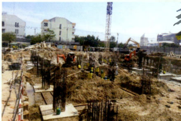
ภาพแสดงฐานรากที่เทคอนกรีตแล้ว
