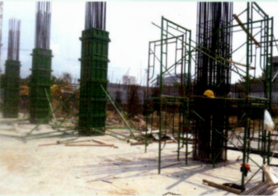
ภาพแสดงการเข้าแบบและผูกเหล็กเสริมเสาตอม่อ
