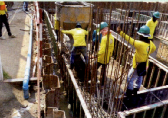
ภาพแสดงการเทคอนกรีตผนังชั้นใต้ดิน
