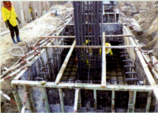
ภาพแสดงการเข้าแบบและผูกเหล็กเสริมฐานราก
