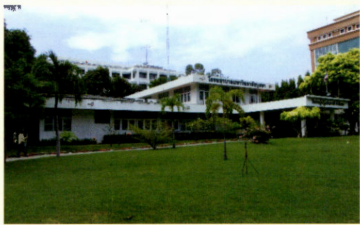
ภาพอาคารท่านผู้หญิงประกาศรี กำสังเอก (เมื่อเปิดศูนย์อุบัติเหตุ-ฉุกเฉิน บริเวณชั้น ๑ อาคารสมเด็จพระเทพรัตนราชสุดา เรียบร้อยแล้ว) บันทึกเมื่อ ๒๒ กันยายน พ.ศ. ๒๕๕๖
