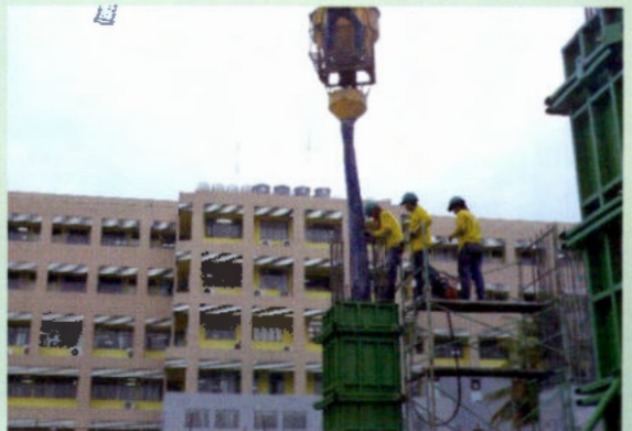
ภาพแสดงการเทคอนกรีตเสาตอม่อชั้นใต้ดิน
