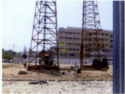
ภาพแสดงการตอกเสาเข็มทดสอบ
