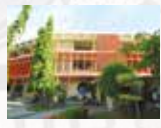
4. อาคารเคมี พื้นที่ใช้สอย 2,850 ตรม.
