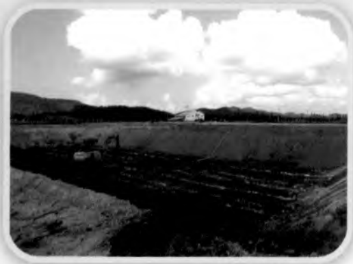
ปรับปรุงพื้นที่บ่อ ทำการวางแนวท่อก๊าซ
