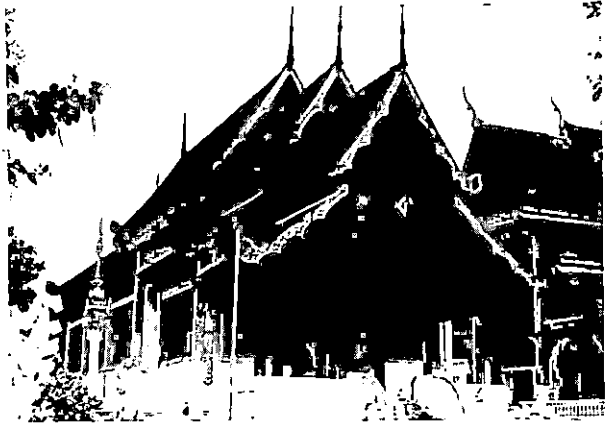
- พระอุโบสถวัดพระสิงห์ สถาปัตยกรรมทรงอาคารของล้านนาระยะหลัง สร้างช่างฟื้นฟูเมืองเชียงใหม่ของพระเจ้า กาวิละ ลักษณะยกฐานสูง และมุขโถงทางด้านหน้า ผนังส่วนบนเป็นไม้ปักทับทั้งหมด
