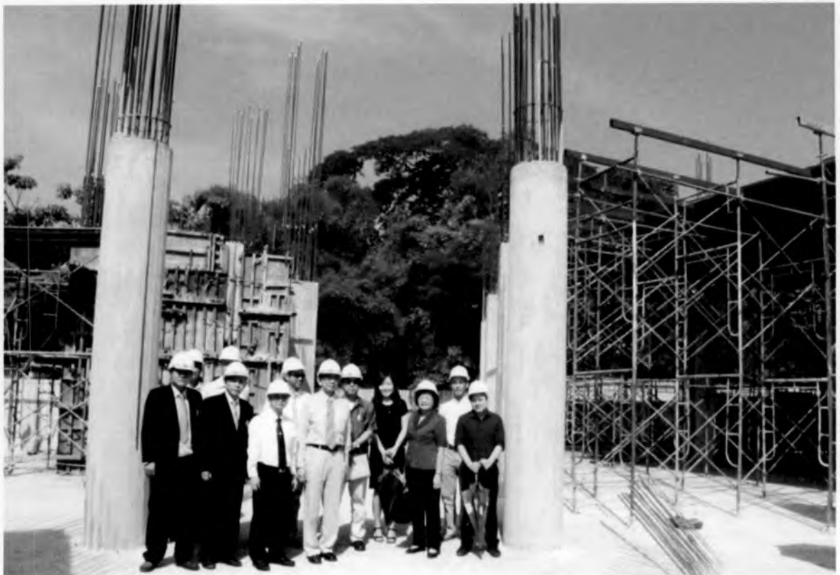
ภาพการตรวจเยี่ยมสถานที่ก่อสร้างอาคารนวัตกรรมการจัดการและการท่องเที่ยว
