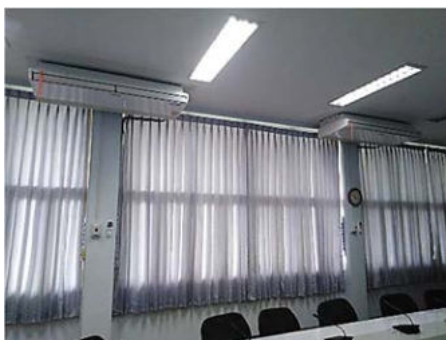
ภาพการปรับเปลี่ยนเครื่องปรับอากาศแบบประหยัดพลังงาน เบอร์ ๕ และเปลี่ยนหลอดไฟในอาคารเป็นฟลูออเรสเซนต์ภายในอาคารเป็นหลอดประหยัดพลังงานแบบ LED
