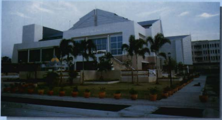
อาคารหอประชุมอ่างบัวศรี
