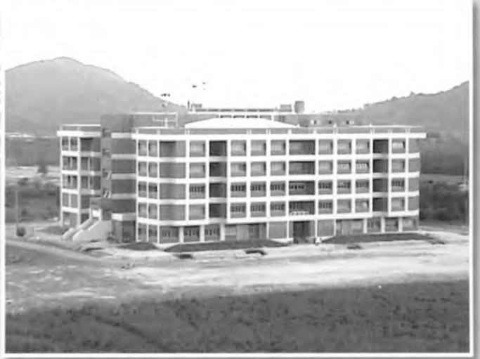
อาคารเรียนรวม
